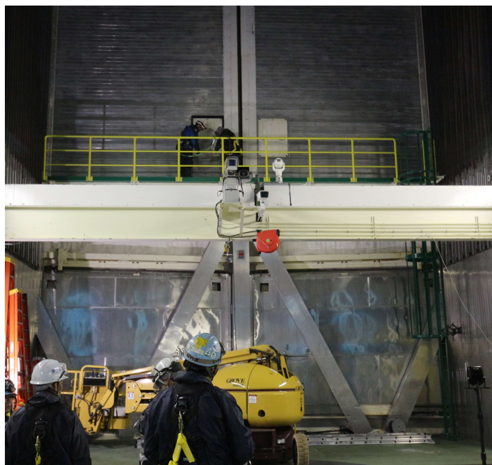
図3 メインシャッター前部に設置した歩廊と昇降設備
