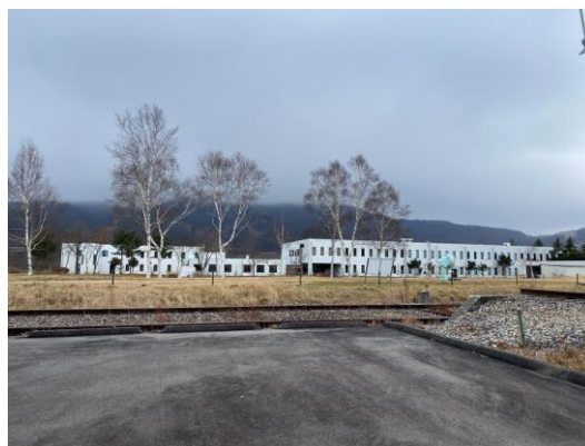
本館全体 CE(液化窒素タンク)も撤去した
