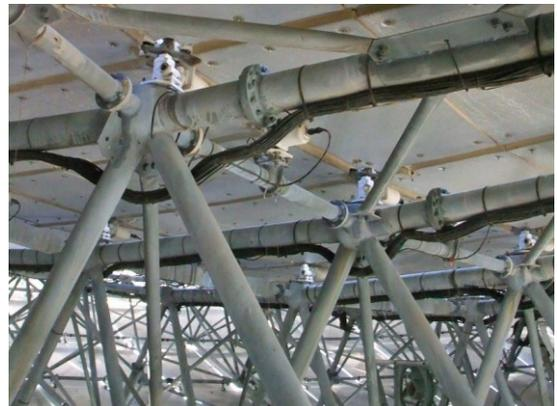
図 2 45m 主鏡骨組内のトラス構造
