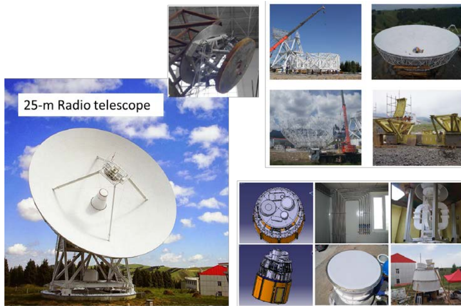
図3 中国科学院新疆天文台南山観測局25 m電波望遠鏡(図右側に示す改修が行われています)
