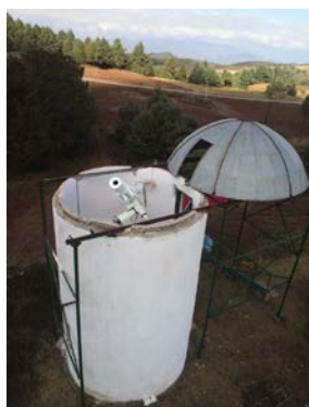
図6.仮設置したドーム
