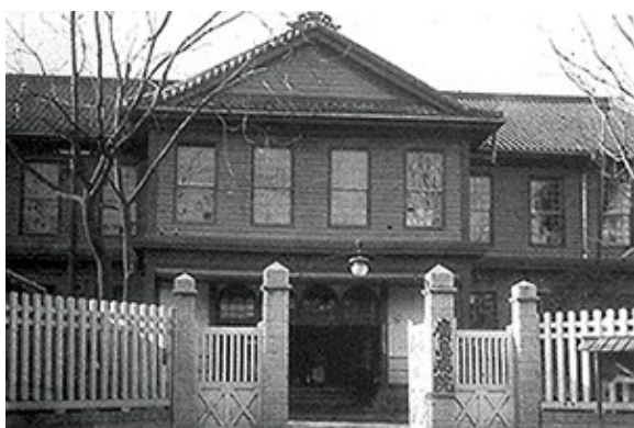
図 25 広島県立病院創建時の正門と本館建物 (大正 4 年)
